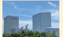
▲スプレッドライヤー6号機(建屋右側)
